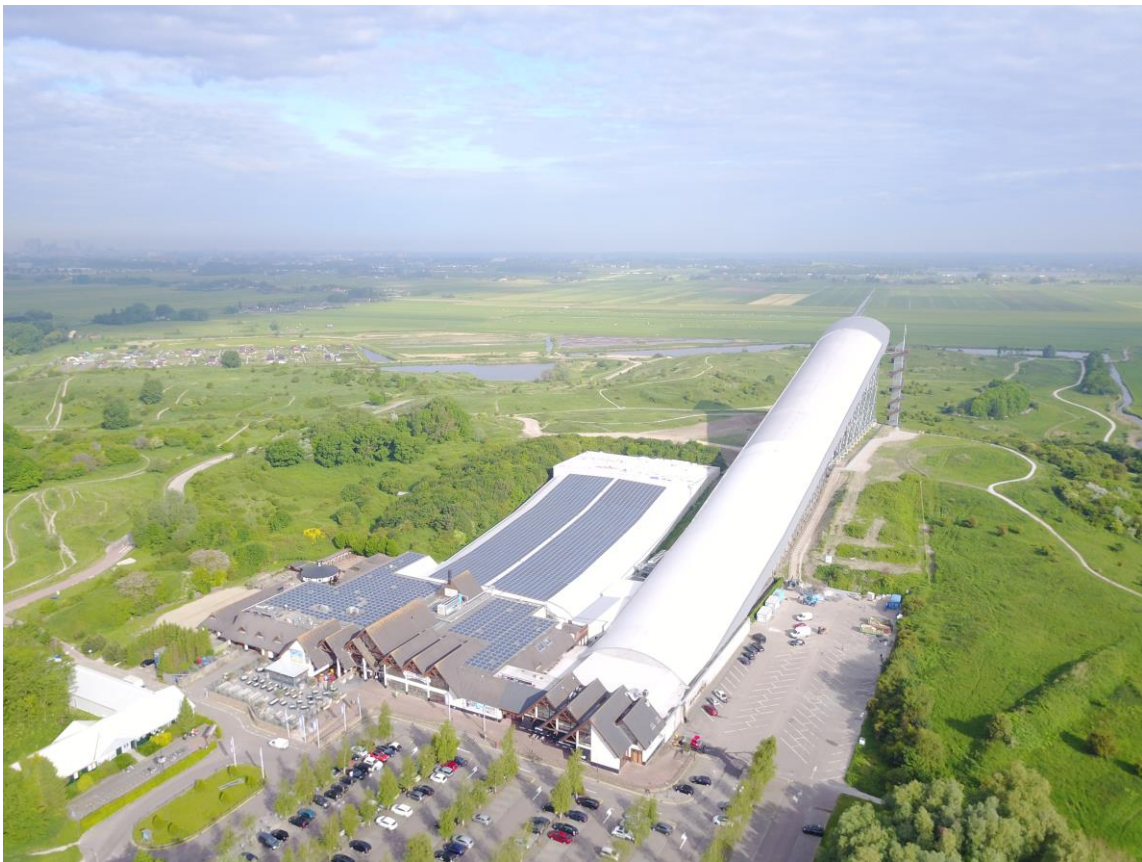
3.000 zonnepanelen op de daken van de pistes van SnowWorld Zoetermeer
